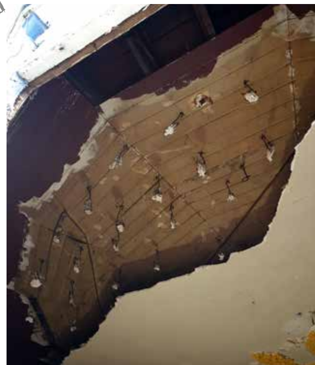
Découverte des plafonds bois de la véranda, cachés derrière des décors staffs rapportés postérieurement.
